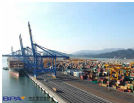
釜山新港(北側)のコンテナターミナル
